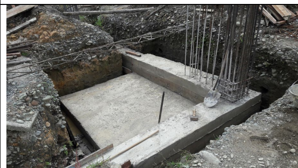
Armado de acero para zapatas
