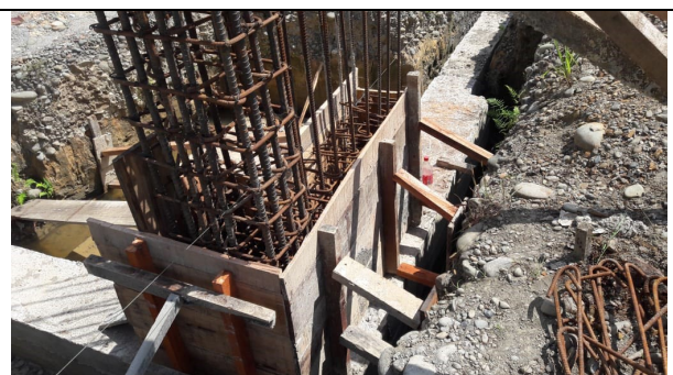
Armado de acero para vigas de cimentación
