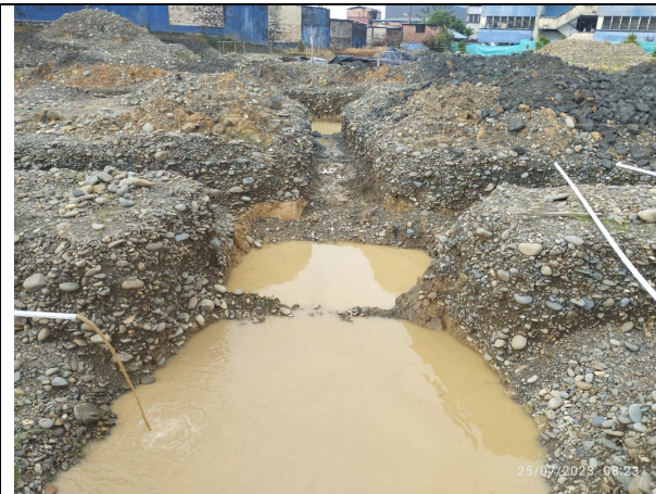
Excavaciones cimentación (vigas y zapatas)
