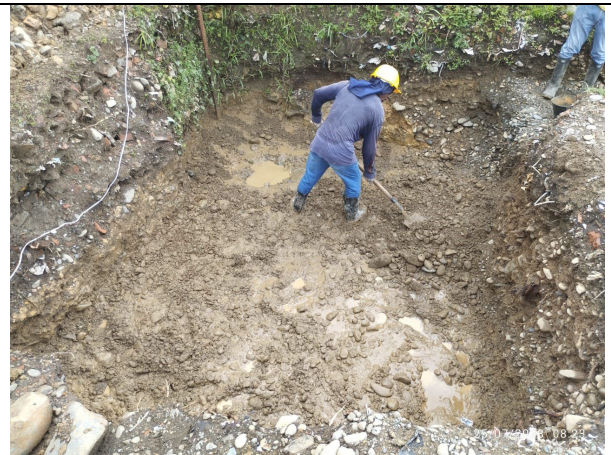
Excavaciones en zapata
