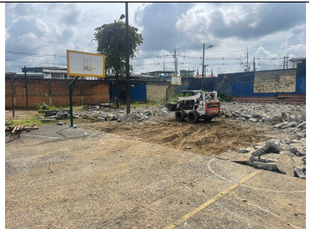
Demolición de losa en concreto – área de cancha
