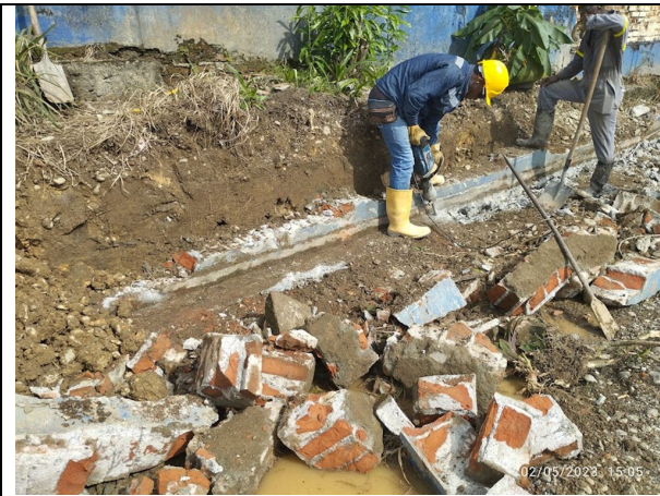
Demolición de muro en ladrillo tolete área de gradería
