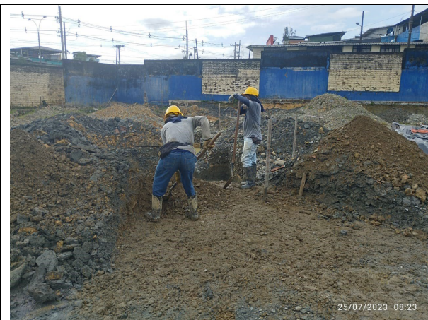
Excavaciones cimentación (zapatas)
