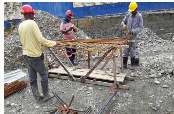
Armado de acero para zapatas
